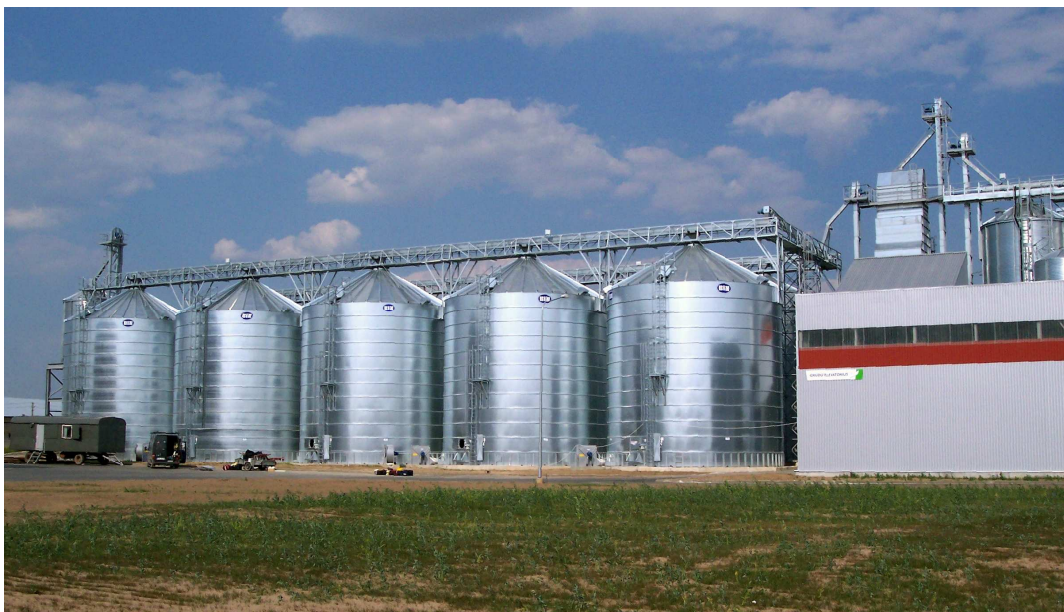
Foto 2. Nowoczesny magazyn zbożowy w układzie rzędownym.
